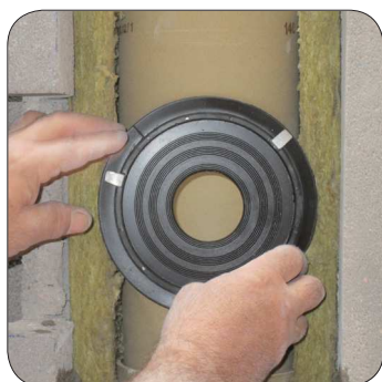
17. Vegyük ki a füstcső-csatlakozóból a papírkartont és illesztjük a helyére a steckadaptert.
